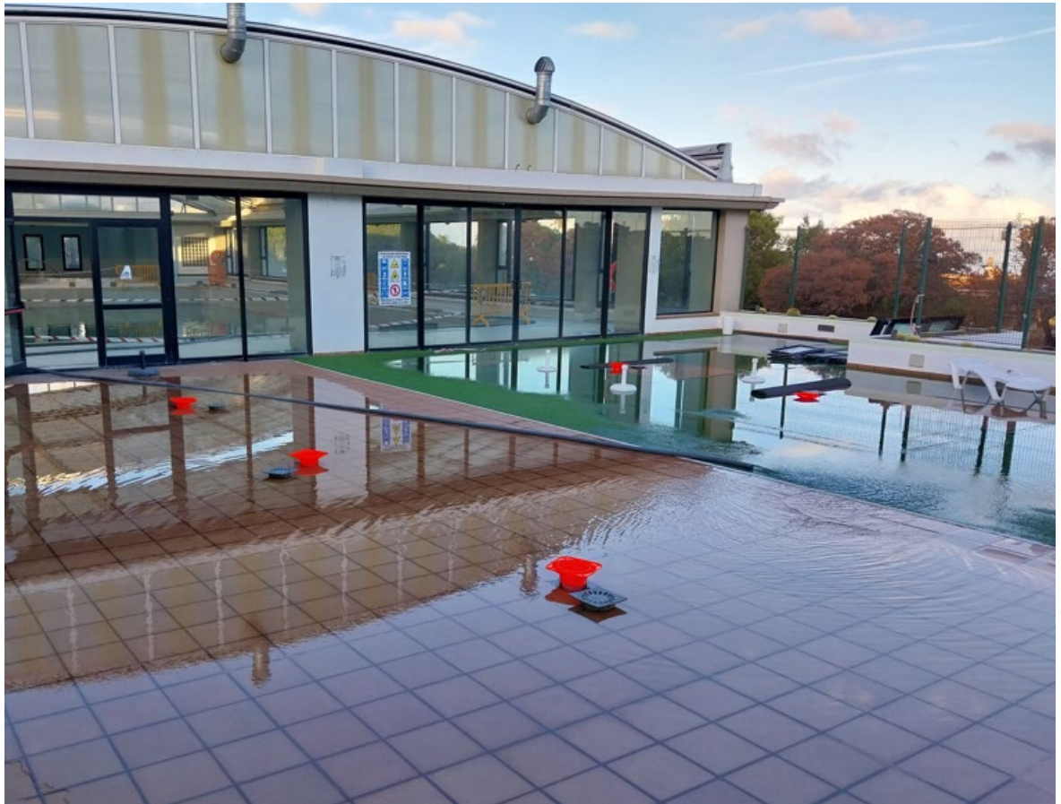
Prueba de estanqueidad solarium exterior.
