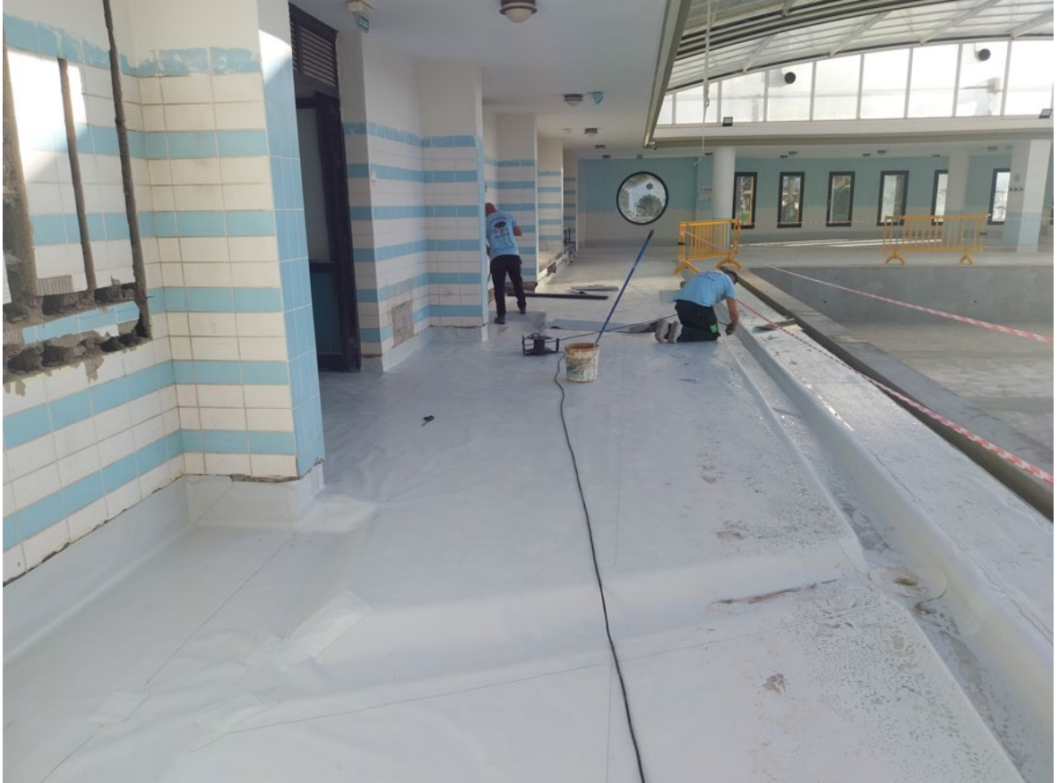
Impermeabilización playa piscina realizada correctamente sin discontinuidades
