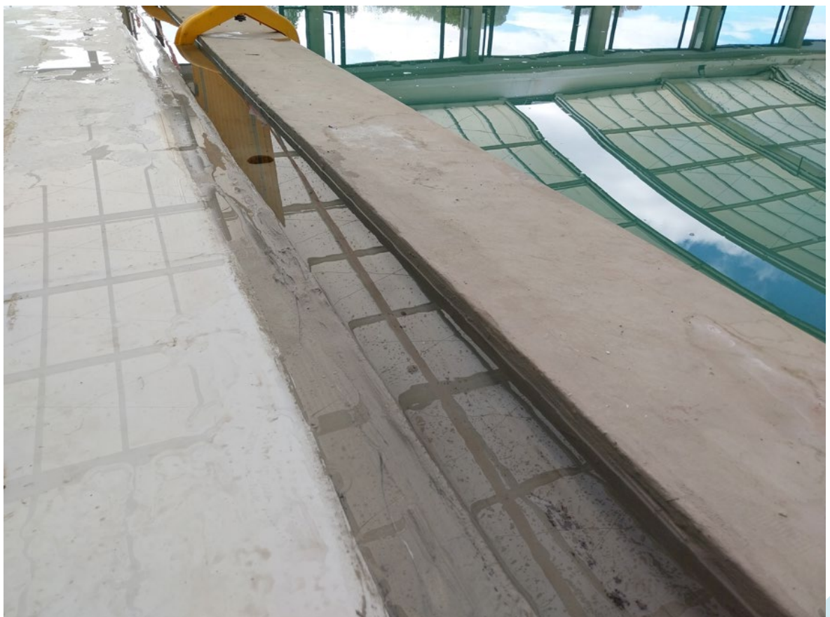
Prueba de estanqueidad 2. Comprobación estanqueidad del canal Munich.
