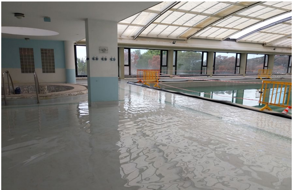
Prueba de estanqueidad 3. Comprobación estanqueidad de la playa exterior.
