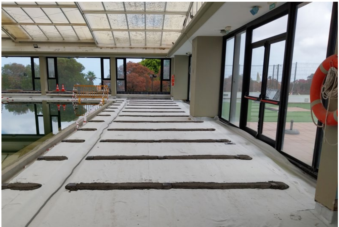
Inicio fase revestimientos recinto piscina
