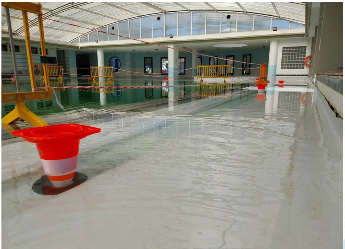
Prueba de estanqueidad 4. Prueba estanqueidad recinto piscina completo.
