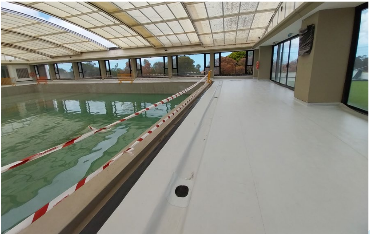
Impermeabilización playa piscina realizada correctamente sin discontinuidades
