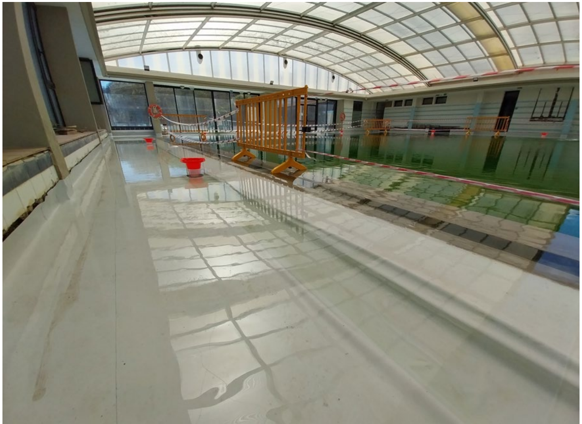
Prueba de estanqueidad 4. Prueba estanqueidad recinto piscina completo.
