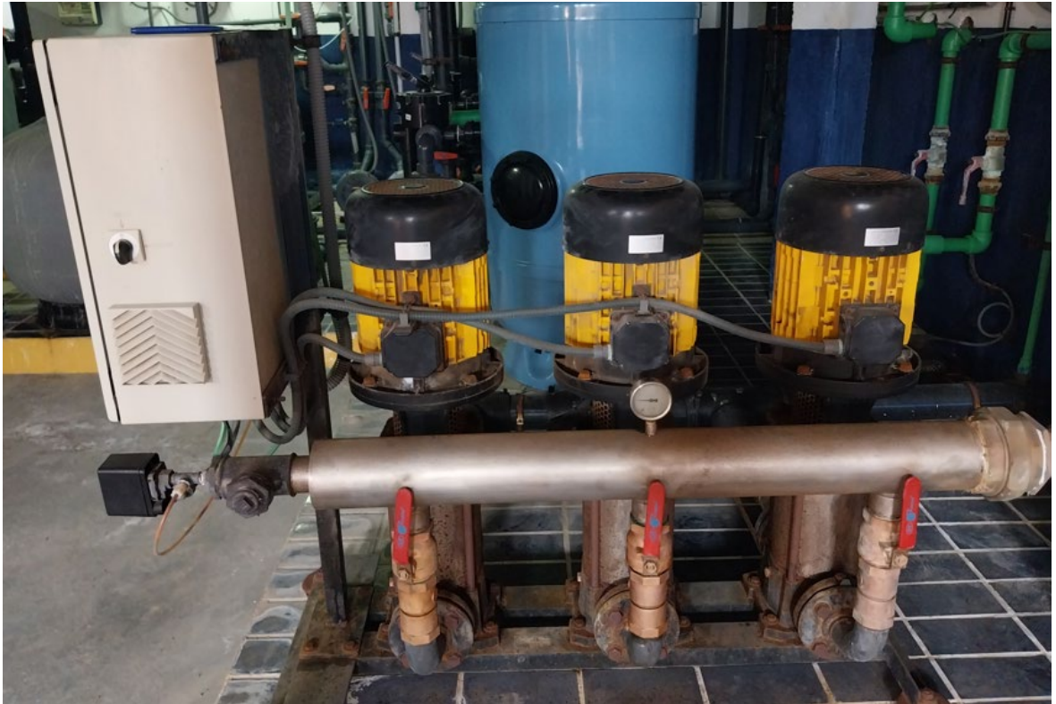
Bombeo del agua de pruebas de estanqueidad al tanque en la zona alta del club
