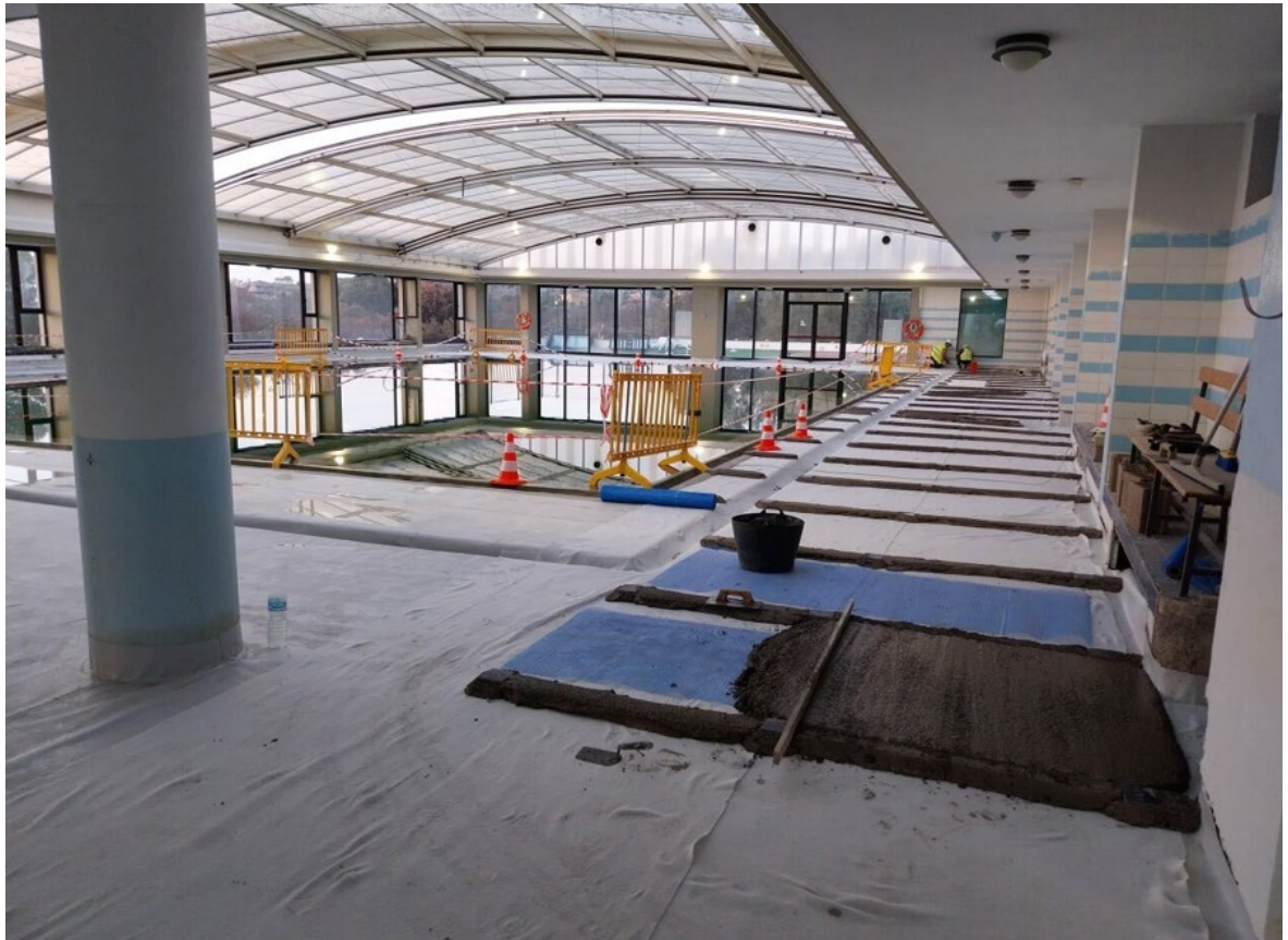
Inicio fase revestimientos recinto piscina
