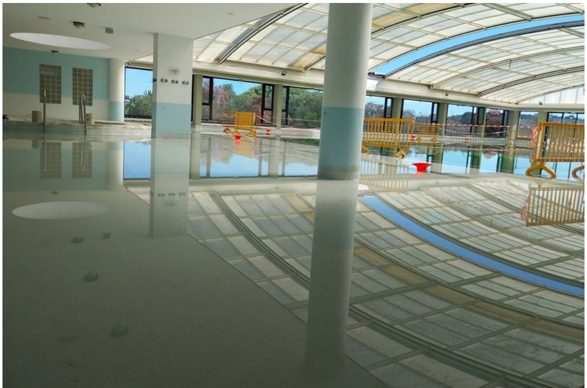
Prueba de estanqueidad 4. Prueba estanqueidad recinto piscina completo.
