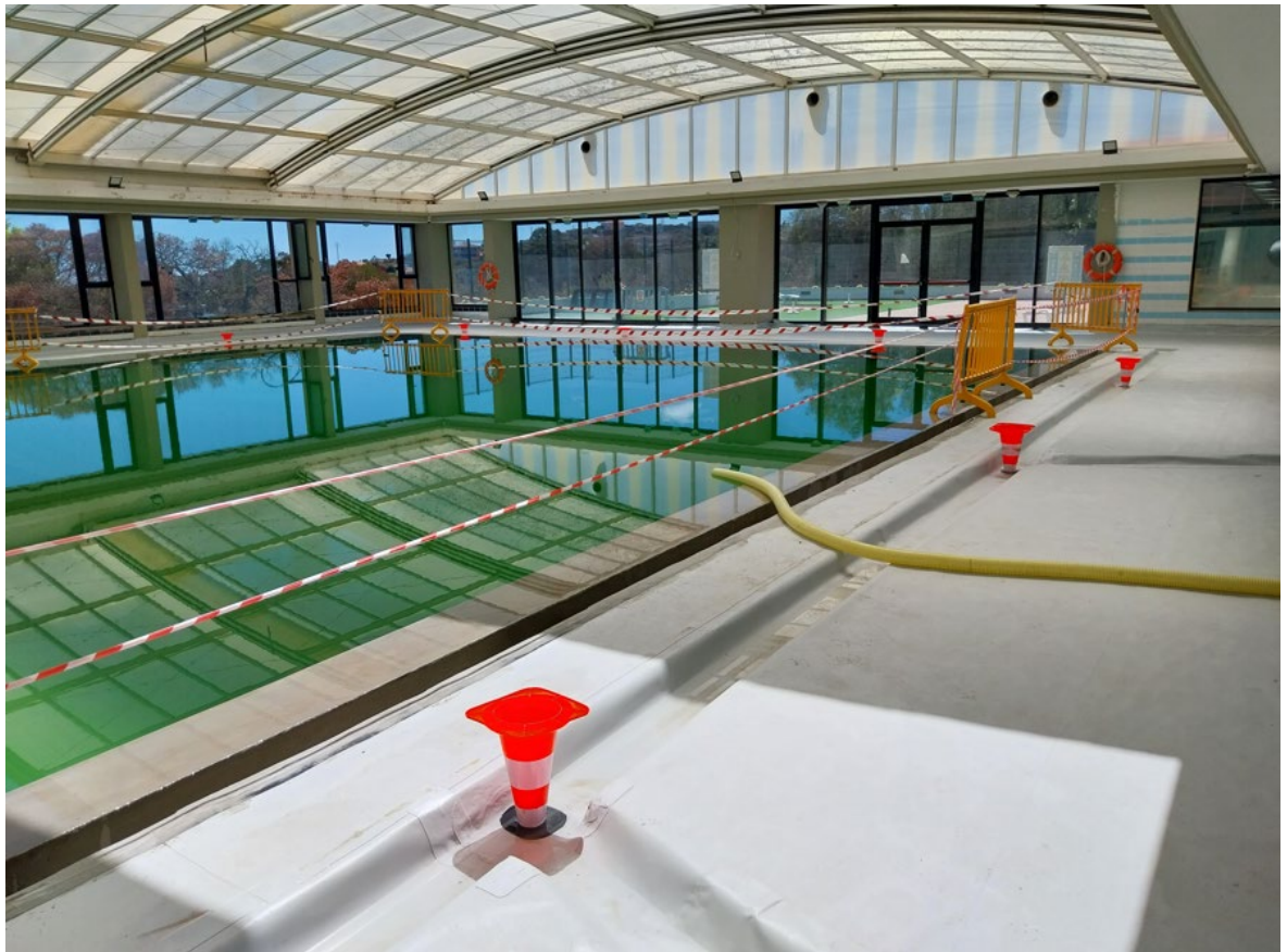
Prueba de estanqueidad 1. Comprobación estanqueidad de la Piscina.
