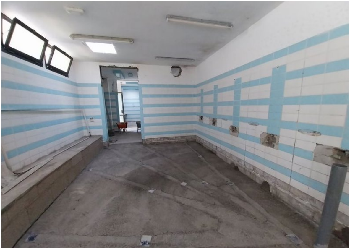
Nueva solera en vestuarios.
